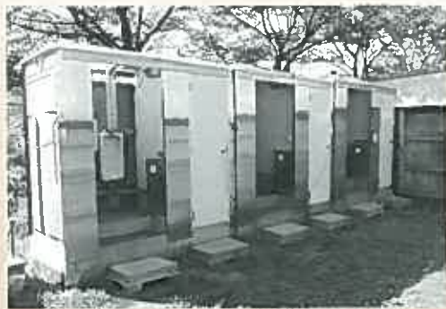
中央公園ソフトボール場の仮設トイレ
