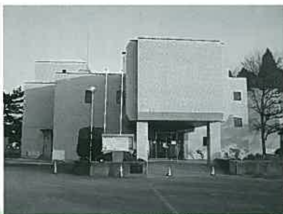
▲多賀城市立図書館
