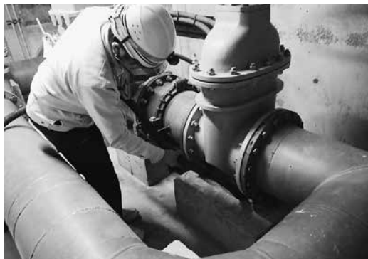
▲水道管工事の様子
