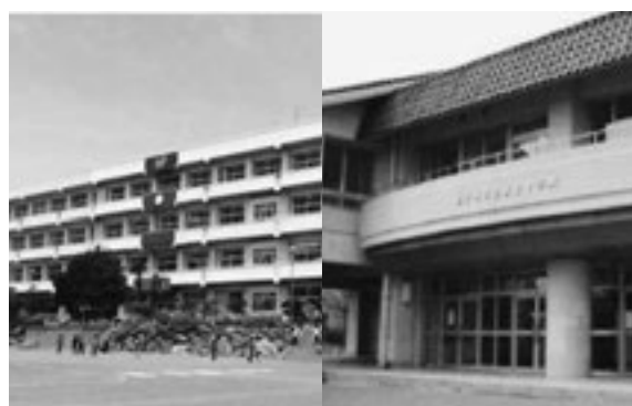
▲多賀城東小学校校舎（左）と 東豊中学校校舎（右）
