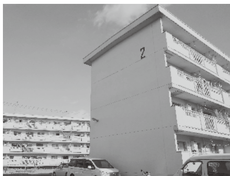
用途廃止の説明が行われる大代市営住宅
