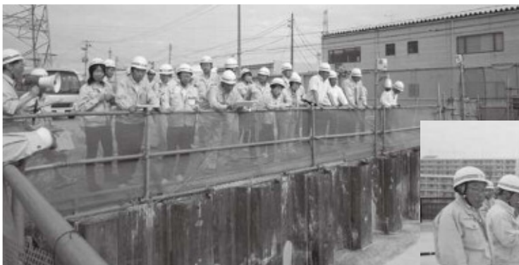
八幡第二雨水調整池
