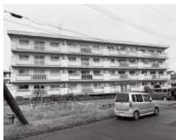
▲大代市営住宅
