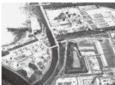
▲宮城県仙塩浄化センター
