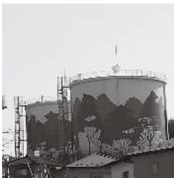
▲天の山配水池
