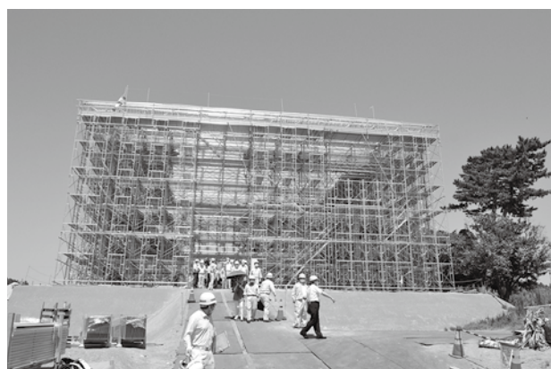
▲南門工事全体像
