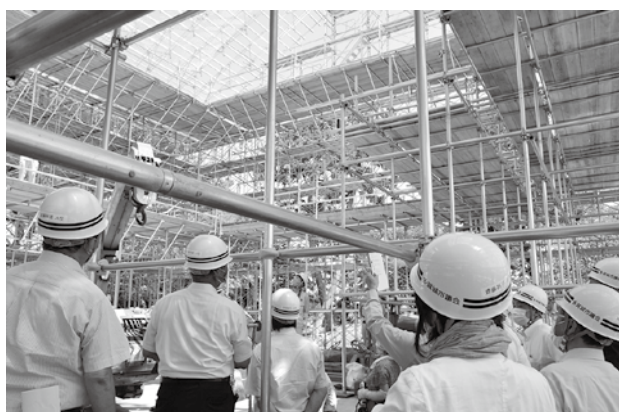
▲南門工事内部
