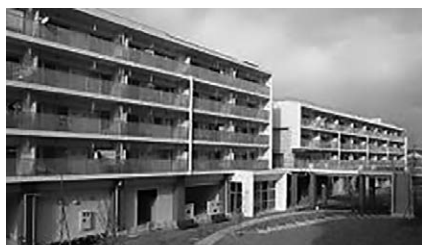
▲災害公営住宅
