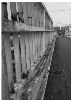
◀ 老朽化した八幡歩道橋(国道45号)
