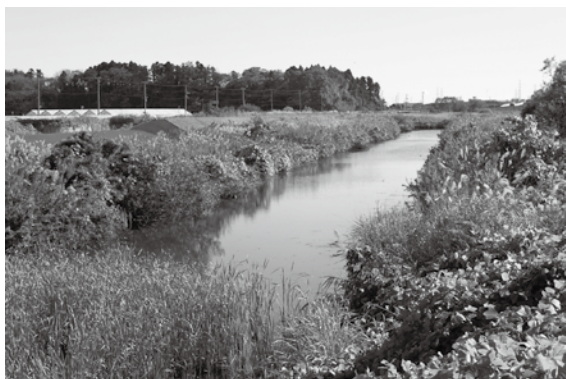
▲一部掘削のみの勿来川遊水地
