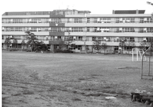
▲山王小学校(大規模改修前)
