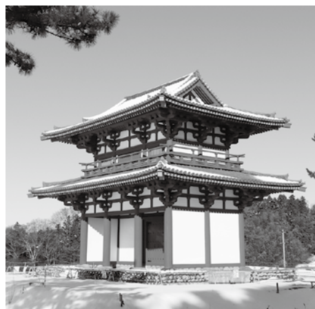
令和4年度に復元された多賀城南門
