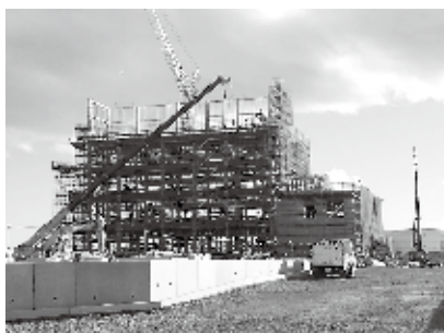
▲蒲生に建設中の2基目の発電所
