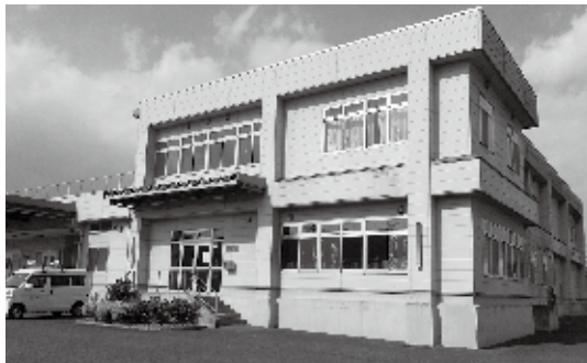
▲ドリームランチ多賀城・給食センター
