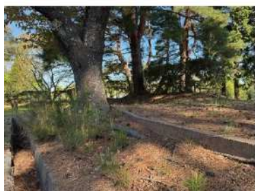
樹木根の被害(多賀城廃寺跡)
