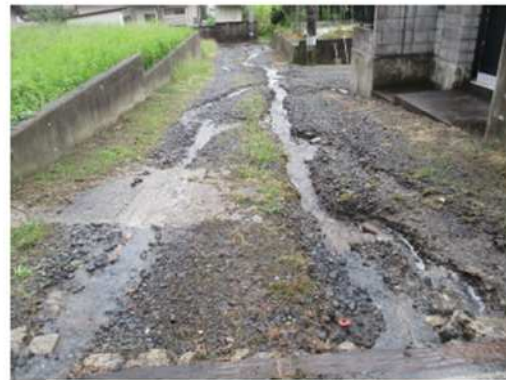
土砂流出(西門・五万崎地区)
