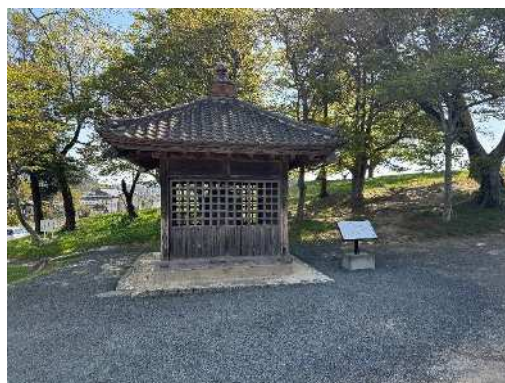
写真32 現在(平成9年改修)の覆屋
