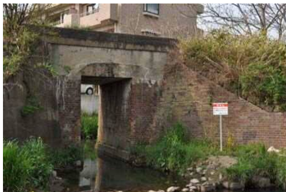
旧塩釜線玉川橋梁
