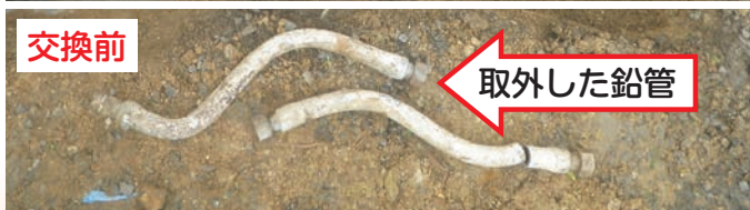
＜実際の鉛製給水管交換作業＞
