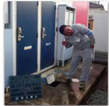
写真:音聴棒による漏水調査
