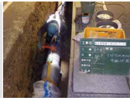
写真:耐震化工事の様子
