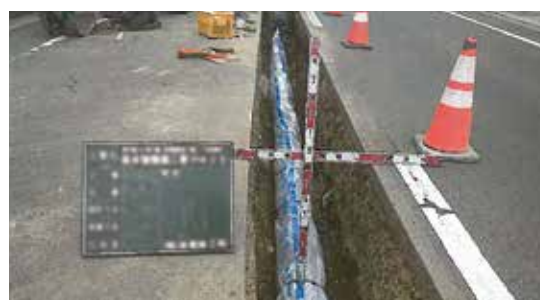
配水管整備工事(八幡二丁目地内)
