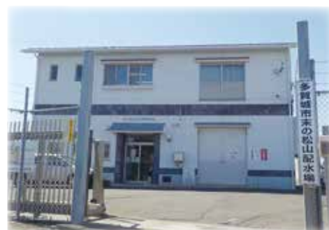
末の松山配水場(多賀城市八幡二丁目)
