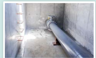
新設高平減圧弁室内 （平成30年度末時点）
