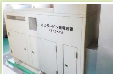
既設発電装置
