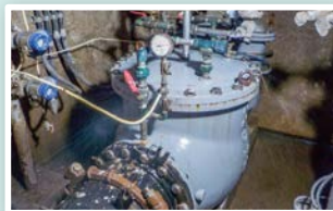
既設高平減圧弁
