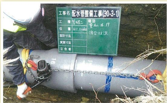
口径400mm耐震管布設状況(笠神八幡線)
