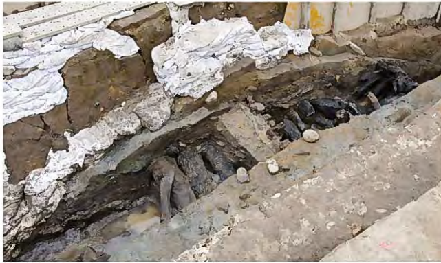
写真② SX2959 基礎地業断面（北西から）
