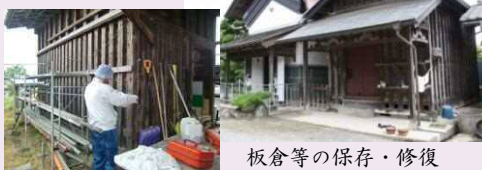
板倉の調査状況
