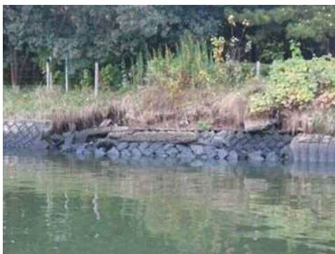
崩落が見られる貞山運河（震災前）
