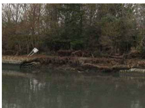
石積の一部が滅失した貞山運河（震災後）
