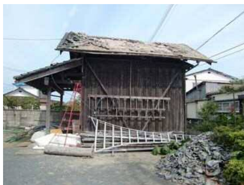
震災被害により崩落が見られる板倉
