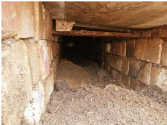
▲切石を積み上げた地下施設
