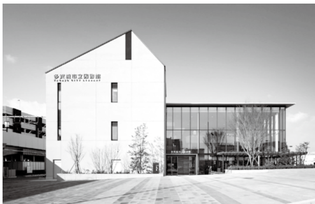
▲多賀城市立図書館
