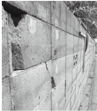
▲市内にある危険なブロック塀
