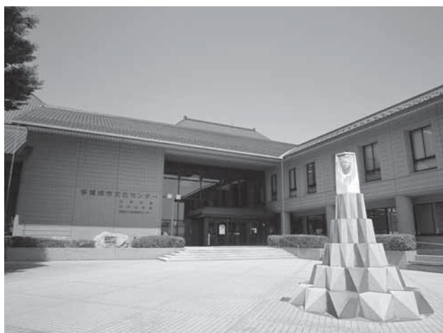
経年劣化したエレベーターを改修する 文化センター
