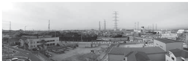
宮内災害公営住宅から見た資源物置場
