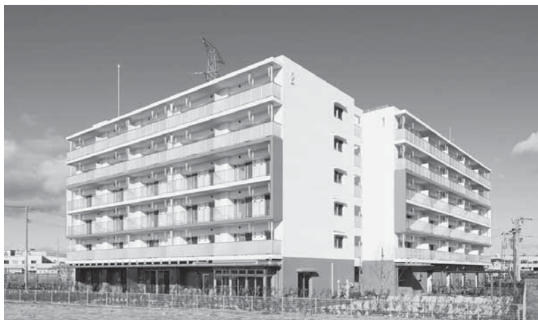
完成した宮内地区災害公営住宅
