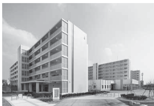
鶴ヶ谷災害公営住宅
