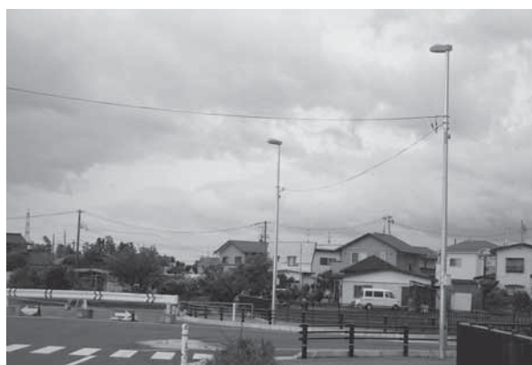
道路公園照明設備
