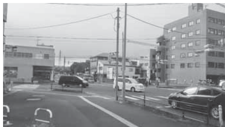
国道45号線下馬付近
