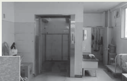
山王小学校荷物専用エレベーター
