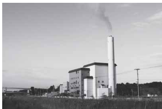
宮城東部衛生処理組合 ごみ焼却施設
