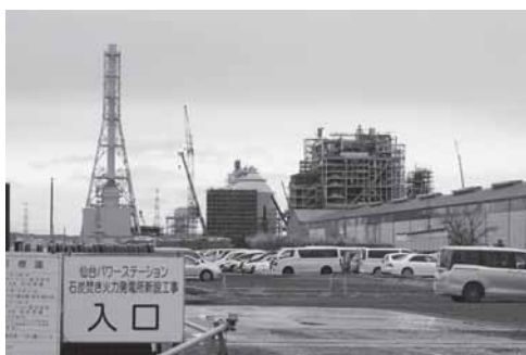
建設中の仙台パワーステーション
