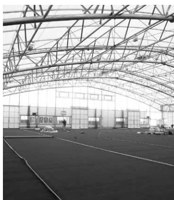
▲完成間近のさんみらい多賀城イベントプラザ
