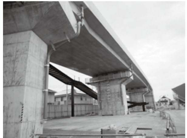
▲清水沢多賀城線(八幡地内)
