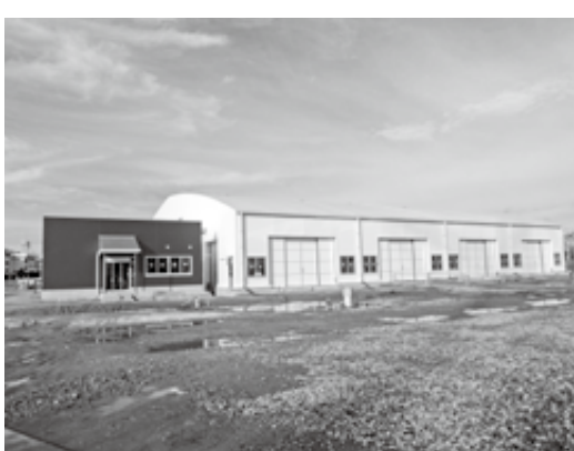
▲防災備蓄倉庫(さんみらい多賀城・復興団地内)
