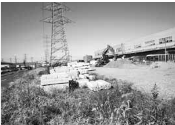
▲整備中の防災緑地(八幡通り公園)
