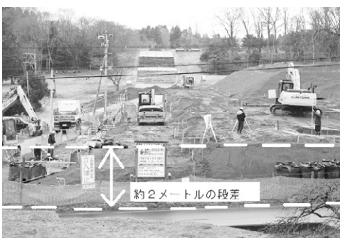
▲いま盛んに行われている「政庁南面地区」の南北大路整備工事
